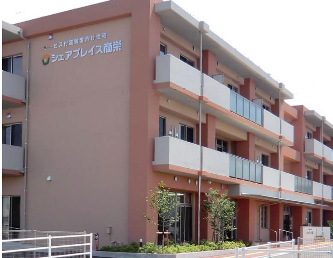
鉄筋コンクリート3階建屋上は緊急避難施設
