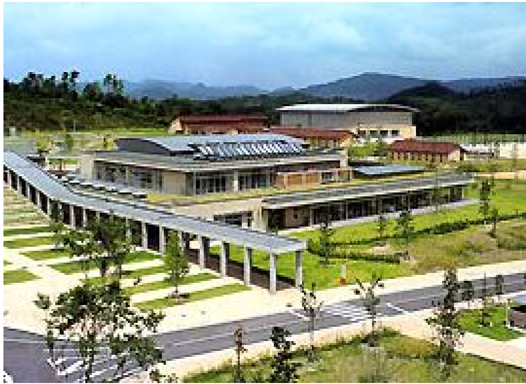
建築施工例：鳥取環境大学
