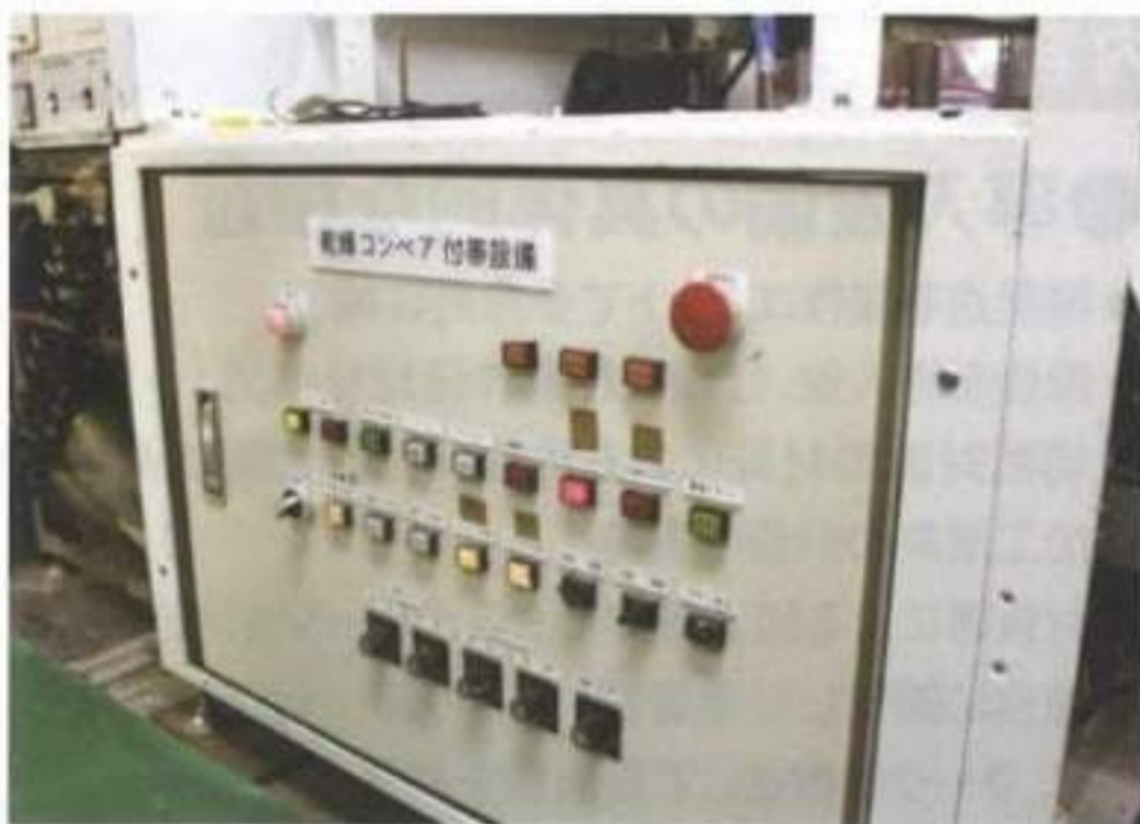
▲工場内のスイッチ盤や船舶の計器盤など様々なところに銘板は使用されている
